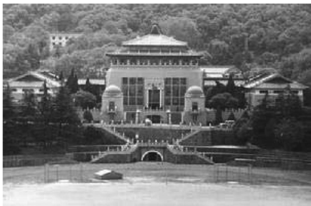
工学院主楼及四栋附楼
